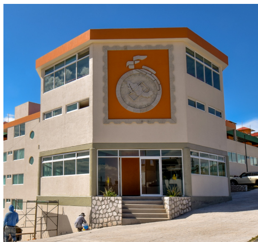
CENTRO SOCIAL Y DEPORTIVO EN MINERAL DE LA REFORMA HIDALGO.
